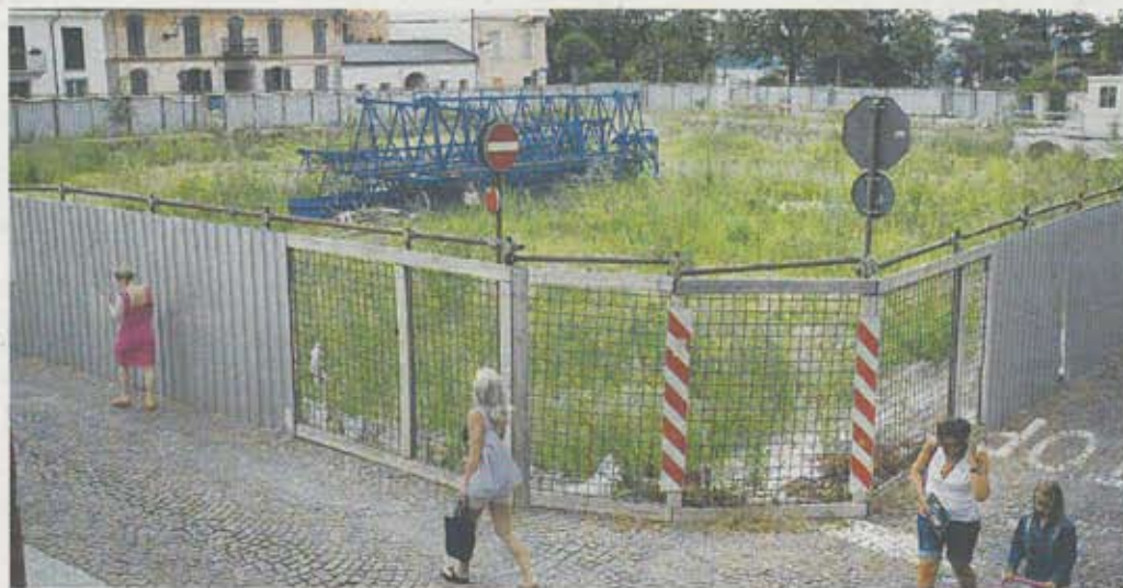
Il cantiere rimasto fermo dopo l'abbattimento dell'ex piccolo arsenale tra corso Giovanni XXIII, via Fratelli Ramorino, vicolo Bisalta e via Alba. (foto Francesco Doglio)
